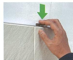
※金具取付け位置に桟木がない場合は、同梱のボードアンカーを使用して取付けをしてください。
